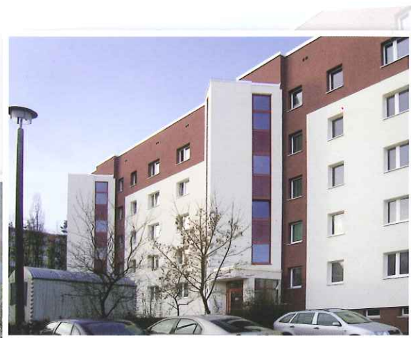
... und nach der Sanierung
