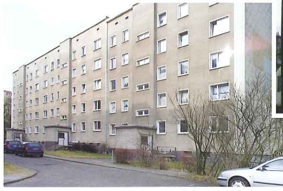
Die Brückenstraße 4-6 vor der Sanierung ...
