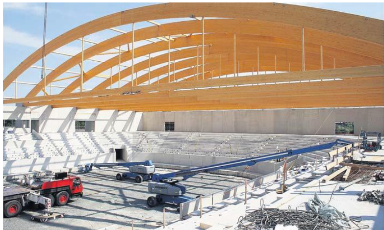
Die Bogenbinder bilden das Skelett des Hallendachs.
