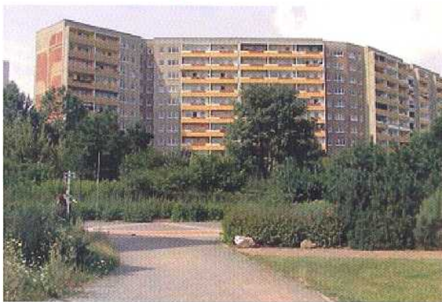
Ludwig-Renn Straße 35-45 vor der Sanierung
